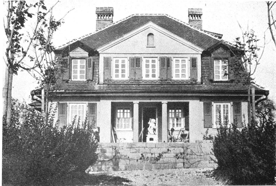
Villa de Mr. Augustin Genoud, architecte FAS, Fribourg
