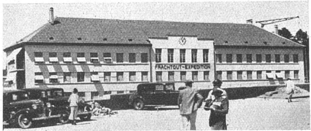
Der neue Güterbahnhof Weiermannshaus SBB
