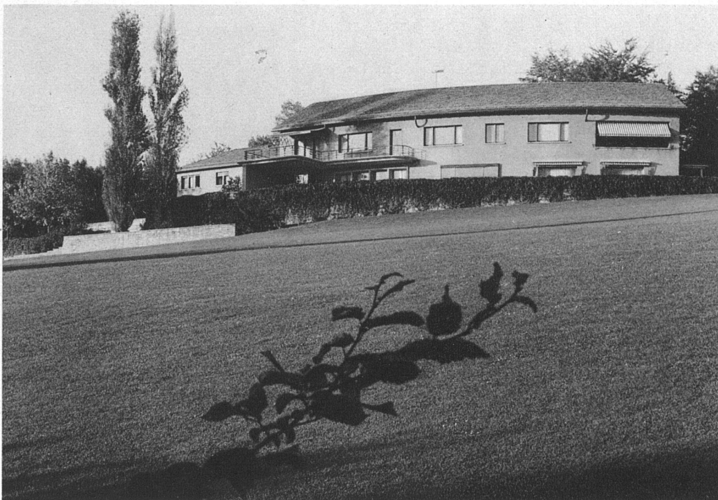
Ansicht aus Süden
