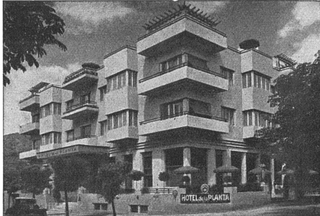
HOTEL DE LA PLANTA, SION (Valais) Architecte: A. de Kalbermatten
