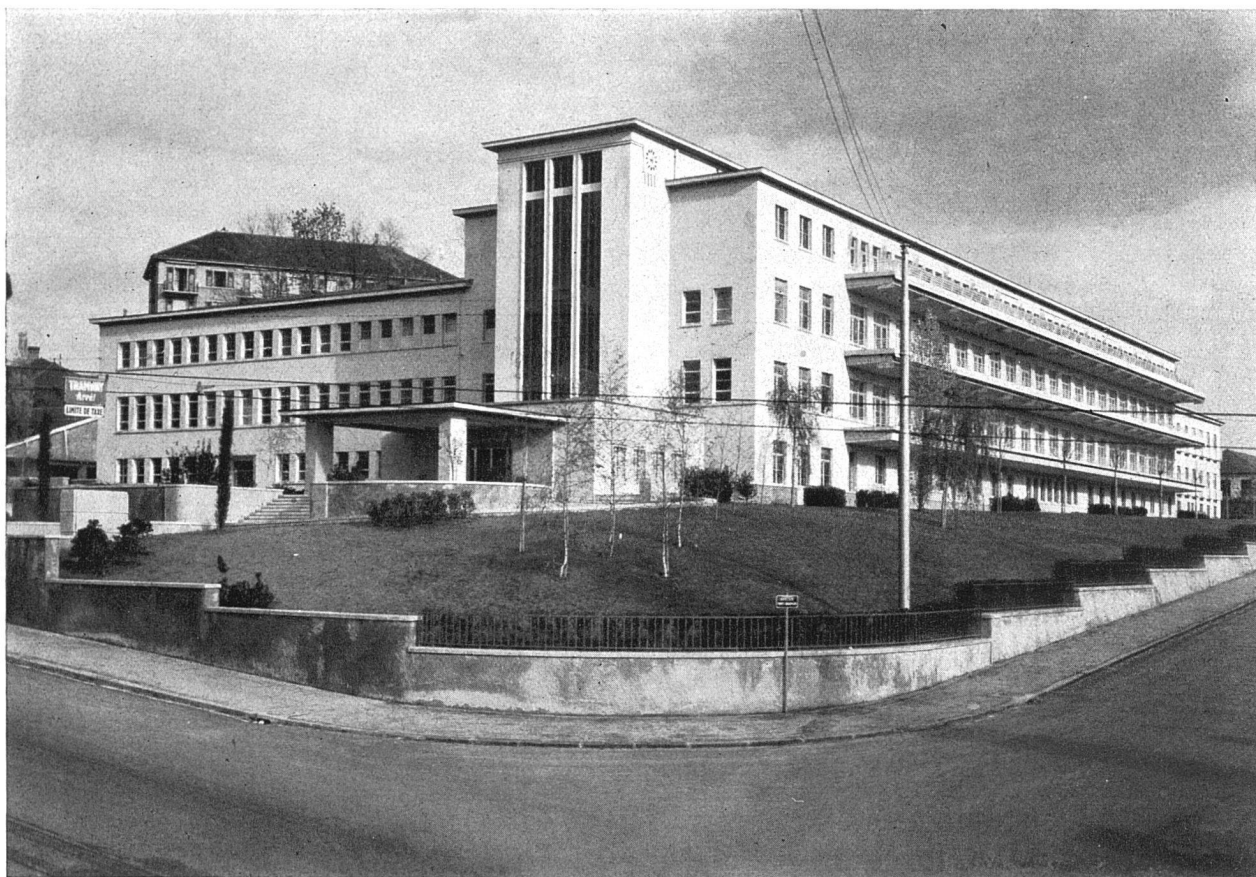
Hôpital Nestlé, Lausanne, angle sud-ouest avec entrée principale. George Epitoux, architecte FAS, Lausanne
