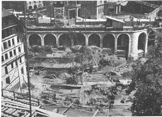
Die Baustelle (künftige Grossgarage) gegen die Kirchenfeldbrücke hin
