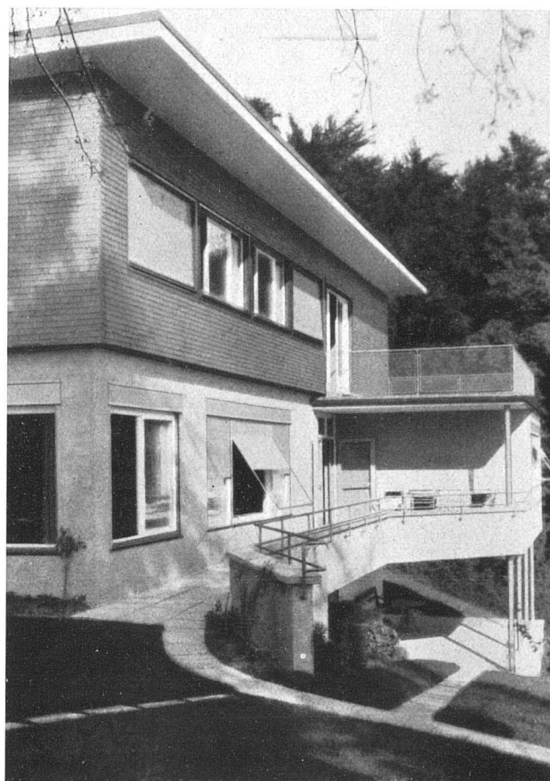
Ansicht von Westen, mit dem gedeckten Sitzplatz und der Veranda
