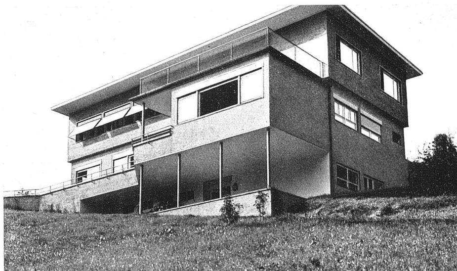
Ansicht aus Nordosten
