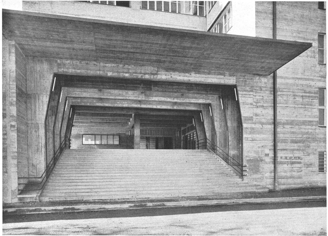
Haupteingang von der Ostseite. Projektierung der Eisenbetonkonstruktion durch das Ing.-Büro Siegwart & Co., Luzern
