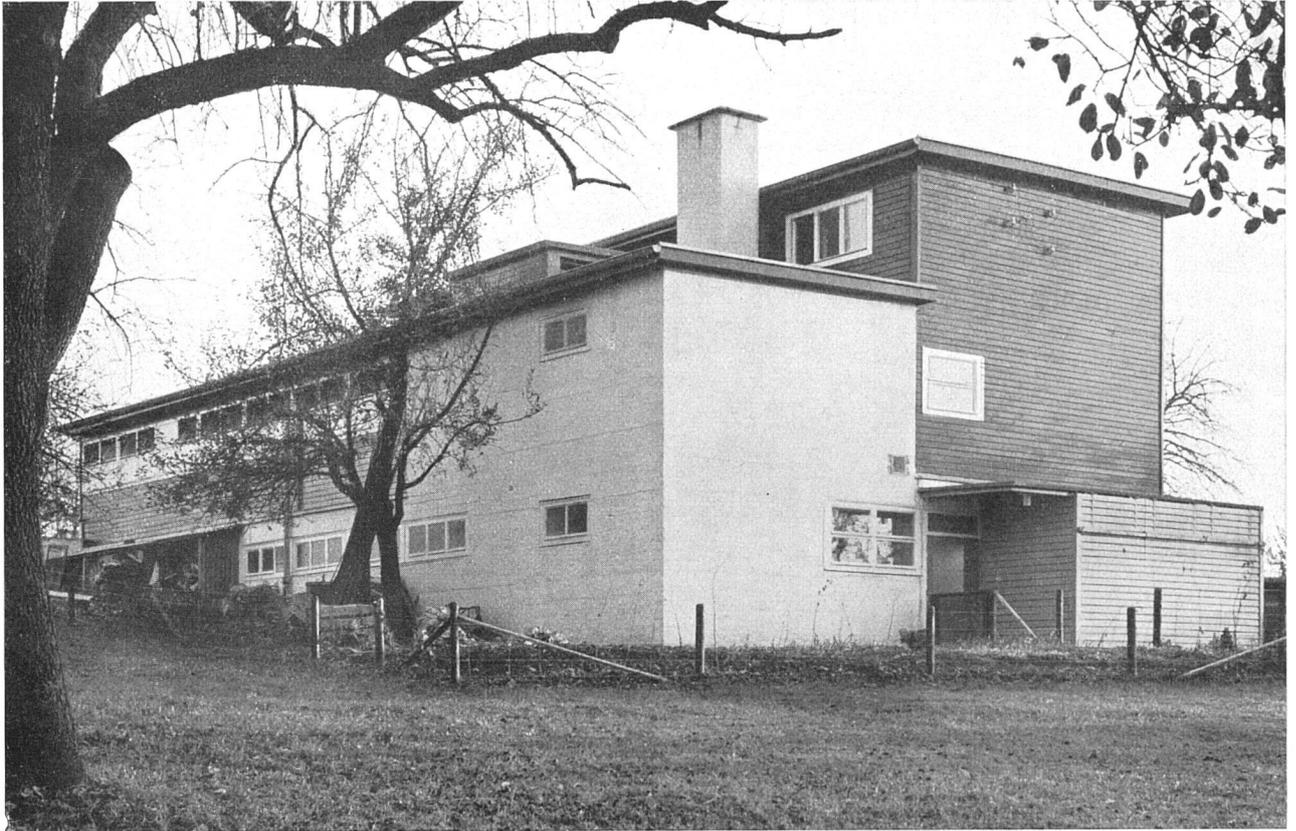
Ansicht von Norden. Links Werkstatt, im unverputzten Betontrakt die Brennöfen, im Anbau rechts Rohstoffvorräte
