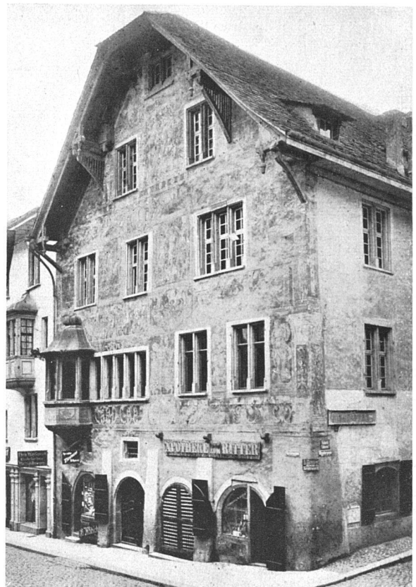
Zustand vor der Renovation von 1919 Der heutige Zustand ist noch wesentlich schlechter
