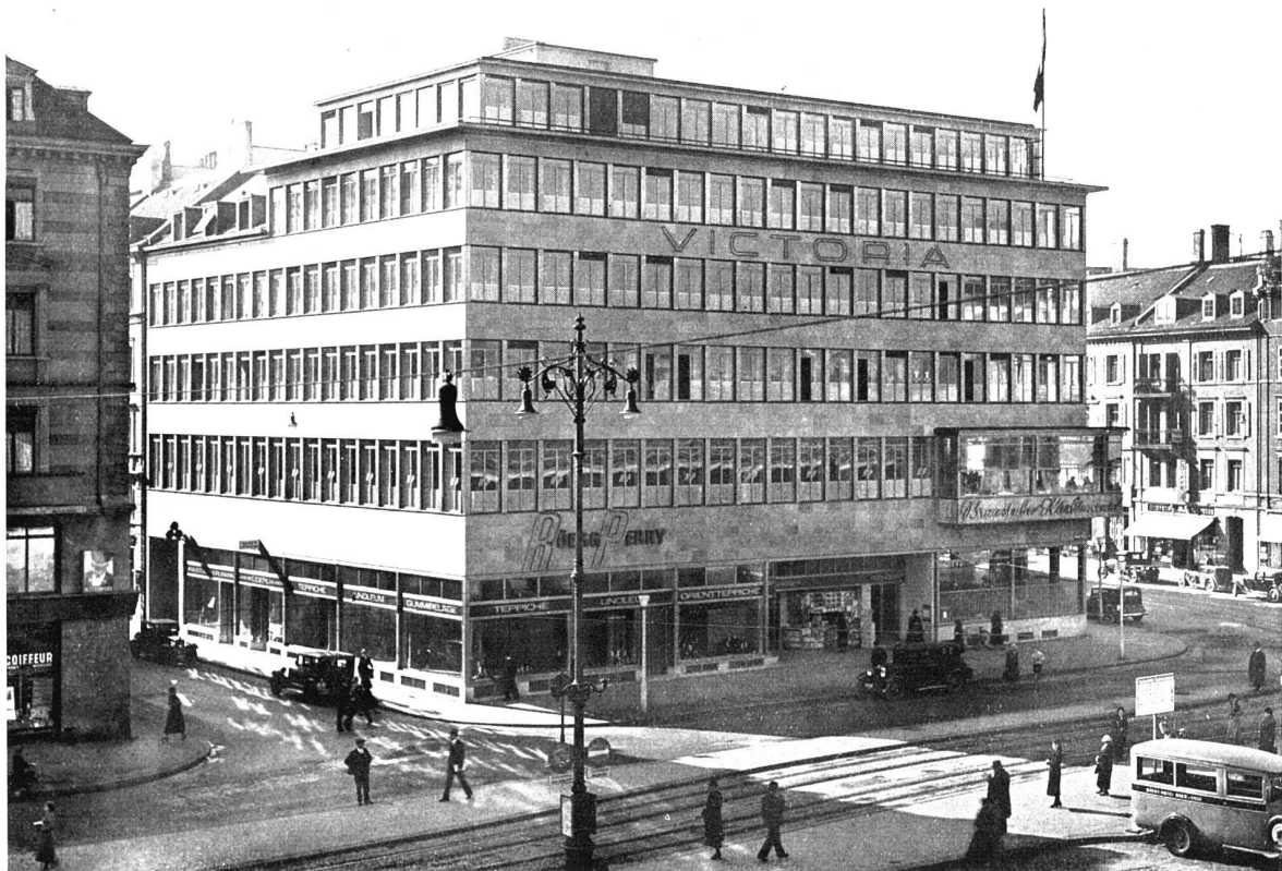
Ansicht aus Nordosten. Ecke Bahnhofplatz-Lintheschergasse
