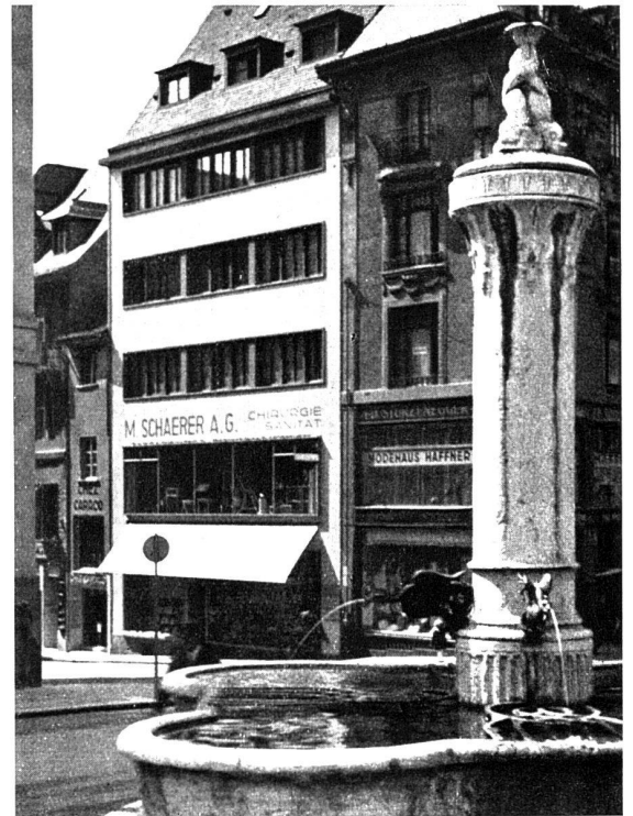
Geschäftshausneubau an der Streitgasse, Basel Eisenskelettbau. Backsteinausmauerung. Fassadenverkleidung in hellgrauen Marbrigitlastafeln. Reine Baukosten Fr. 73.40 per m 2
