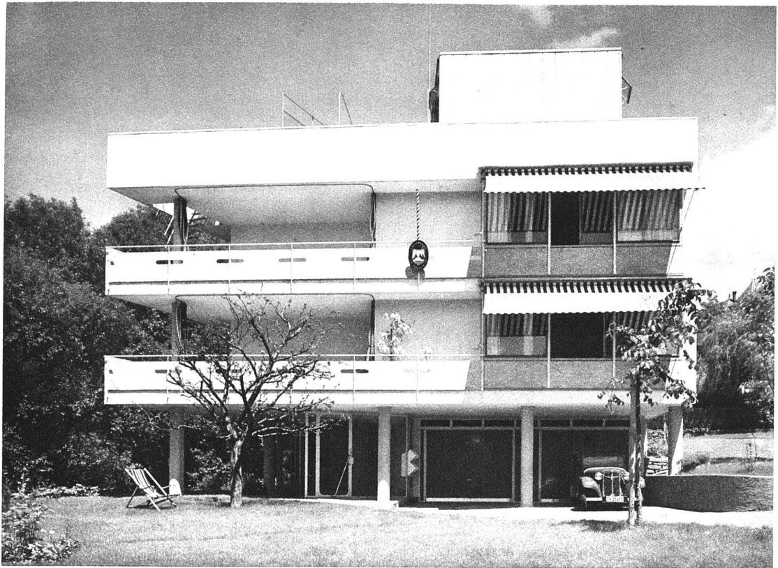
Das obere der beiden Häuser aus Süd-Südwesten
