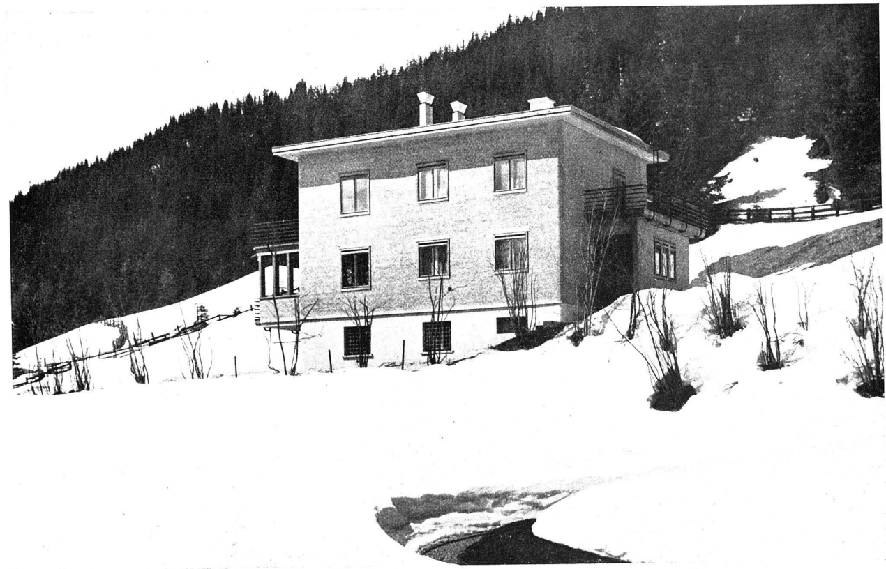
Ansicht aus Nordosten
