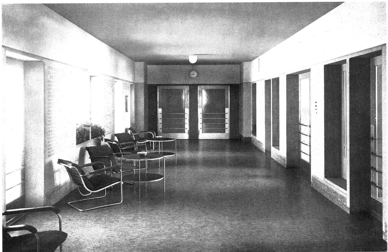
Eingangshalle im Erdgeschoss
