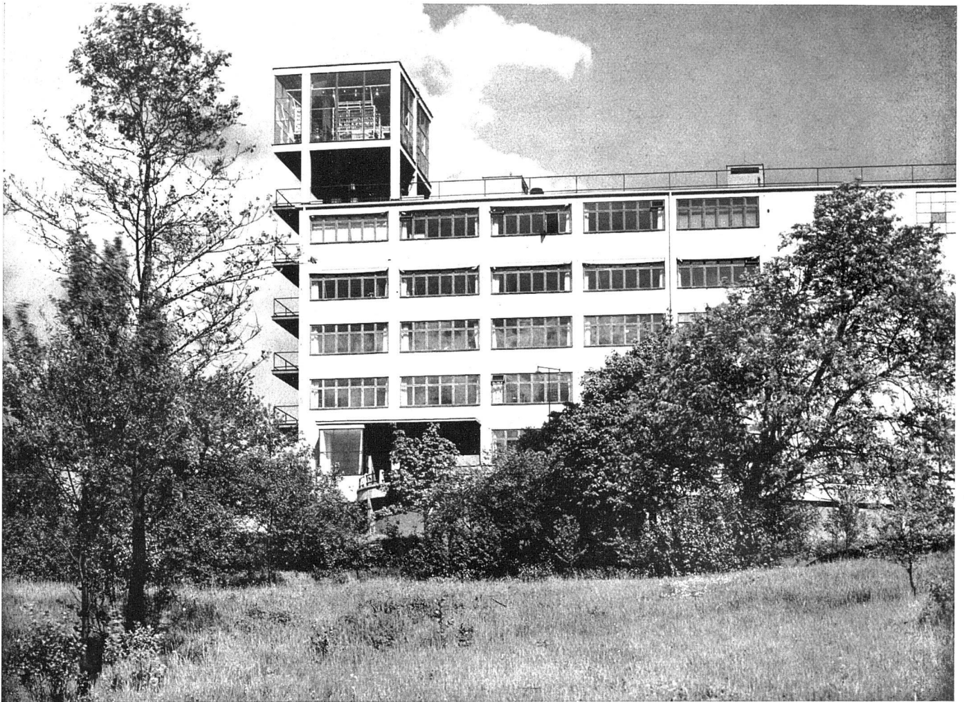
Glühlampenfabrik der Kooperativen Gesellschaft, erbaut 1929/30. Der Stahlständer des Gebäudes ist mit Betonplatten bekleidet. Die Lampen werden in einem Kontrollraum auf dem Dach des Gebäudes revidiert, wo ständig das Licht von 1000 Lampen brennt und als Lichtreklame wirkt. Das Ziel der Kooperativen Glühlampenfabrik war die Verbilligung der Glühlampen, deren Preis vorher von ausländischen Trusts hochgehalten wurde.
