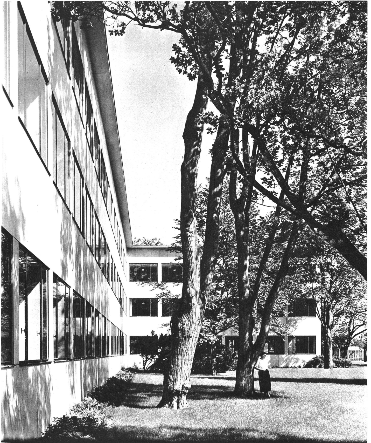
Verwaltungsgebäude der Firma Hoffmann, La Roche & Co. A.-G., Basel Prof. O. R. Salvisberg, Architekt BSA, Zürich Beamtenquertrakt von Süden in Verbindung mit dem Parkgelände
