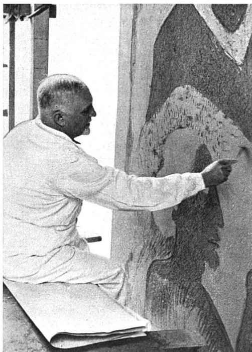
Sgraffito von Cuno Amiet, Bern, an der Aussenwand des Erweiterungsbaues des Berner Kunstmuseums, 1936 ausgeführt in drei übereinandergelegten und wieder entsprechend ausgekratzten Putzschichten. Eine Malerei von sehr viel grösserem künstlerischem Schwung, aber ohne maßstäbliches Gefühl, ohne Bindung an die Architektur und ohne ernsthafte Vertiefung ins Technische und die gegebene bauliche Situation.
