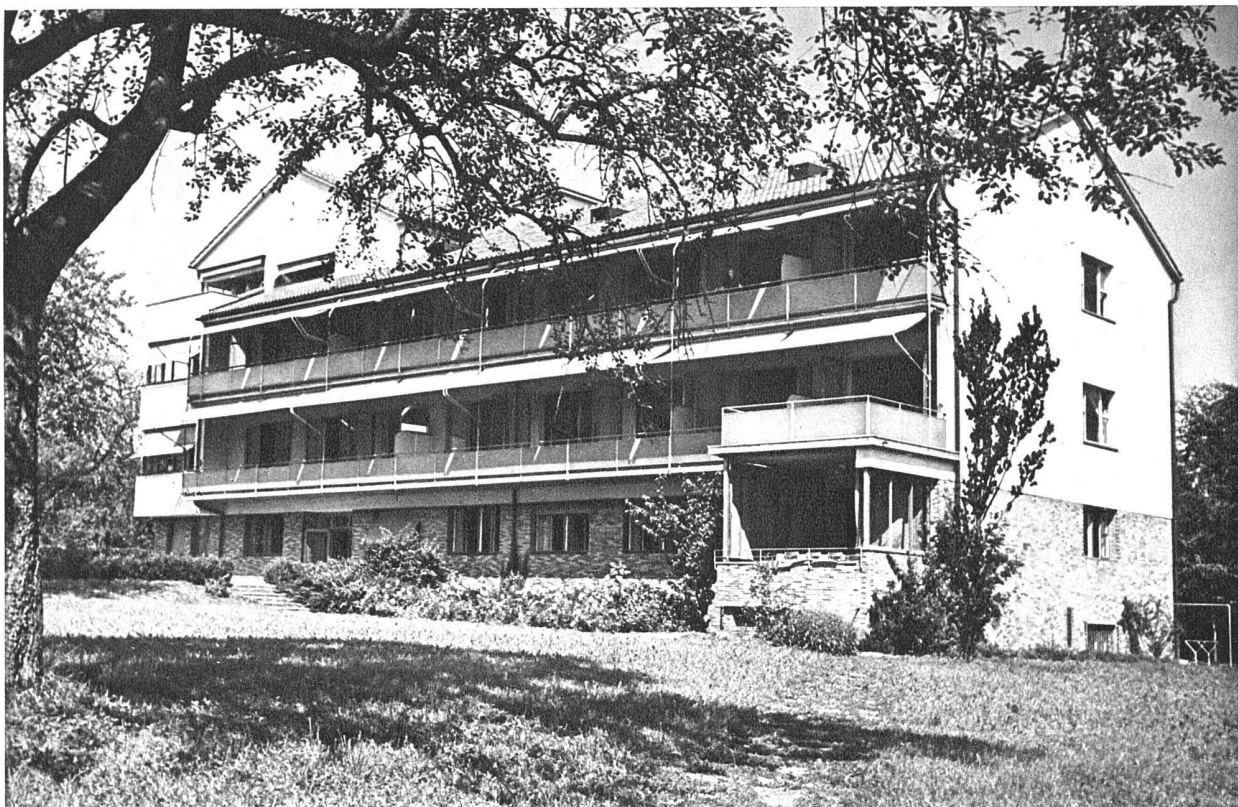
Ansicht aus Südosten
