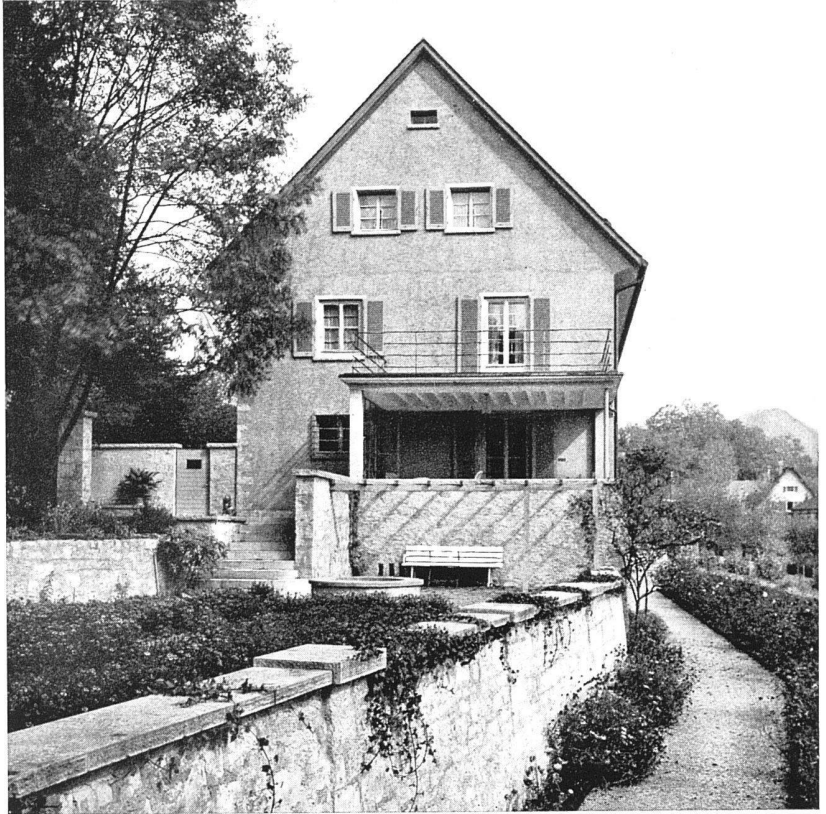
Ansicht aus Südwesten
