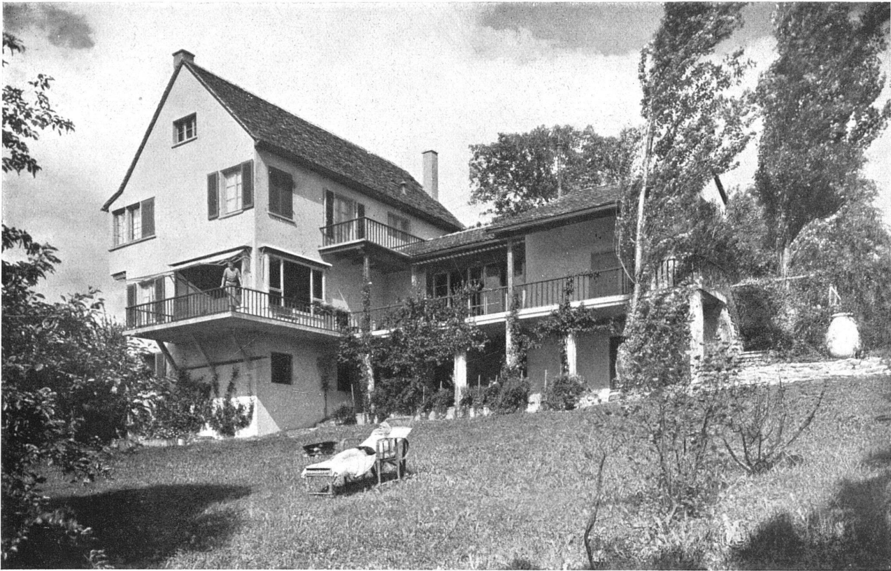
Wohnhaus K. in Zürich-Witikon. Ansicht aus Südwesten
