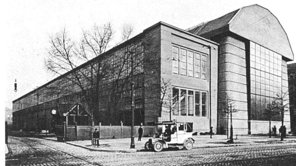
Turbinenhalle der AEG., Berlin-Moabit, Ecke Hutten- und Berlichingenstrasse, 1909. Maschinenmonumentalität
