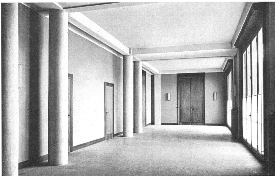
Strassenseite, Eisenbeton-Skelettbau Inneres: Diskrete Monumentalwirkung unter Verwendung der konstruktiven Glieder im Sinne der Gebrüder Perret
