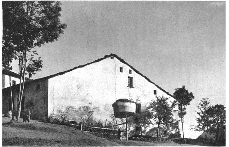
Bauernhaus mit vorgebautem Backofen bei Poschiamo, Graubünden Foto Alb. Steiner, St. Moritz
