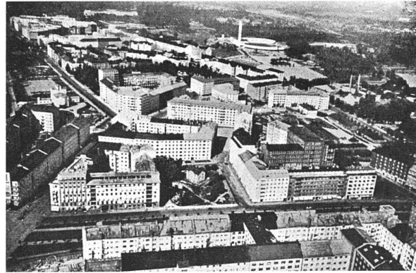
Beide Abbildungen: Helsingfors, Tööli. Typisches neues Wohnquartier des Mittelstandes. 90% der Bevölkerung wohnen in solchen Mietskasernen. Die glatten Fassaden werden dadurch erreicht, dass W.C., Bäder, oft auch Küchen im Innern des Hauses liegen, mit künstlicher Ventilation und Beleuchtung (in Schweden auch die Treppenhäuser)
