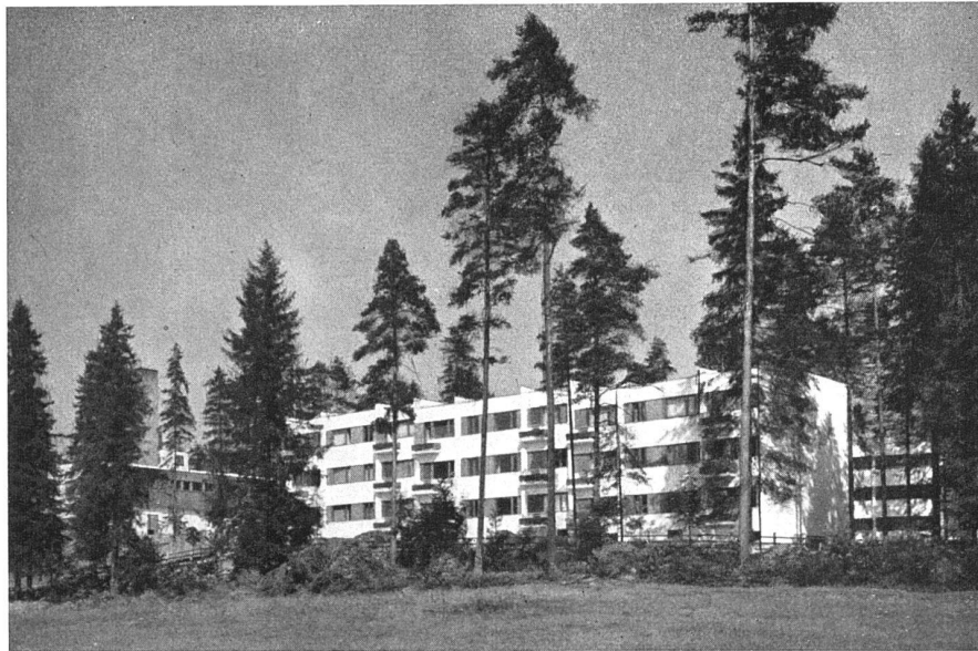
Dreigeschossige Miethäuser, ähnlicher Grundriss wie unten.
