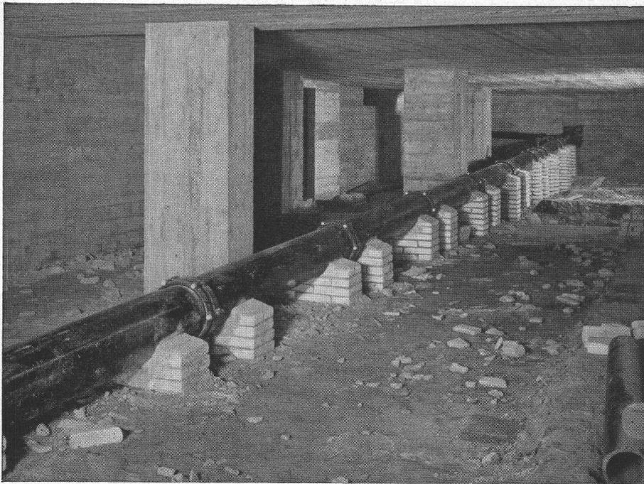
Muffenlose Eternit-Ablauf-Rohre kamen im Rhätischen Kantons- und Regionalspital, Chur, in einem Ausmass von über 2 km zur Anwendung. Eternit-Installations-Rohre sind schnell verlegt, schallhemmend und dauerhaft.
