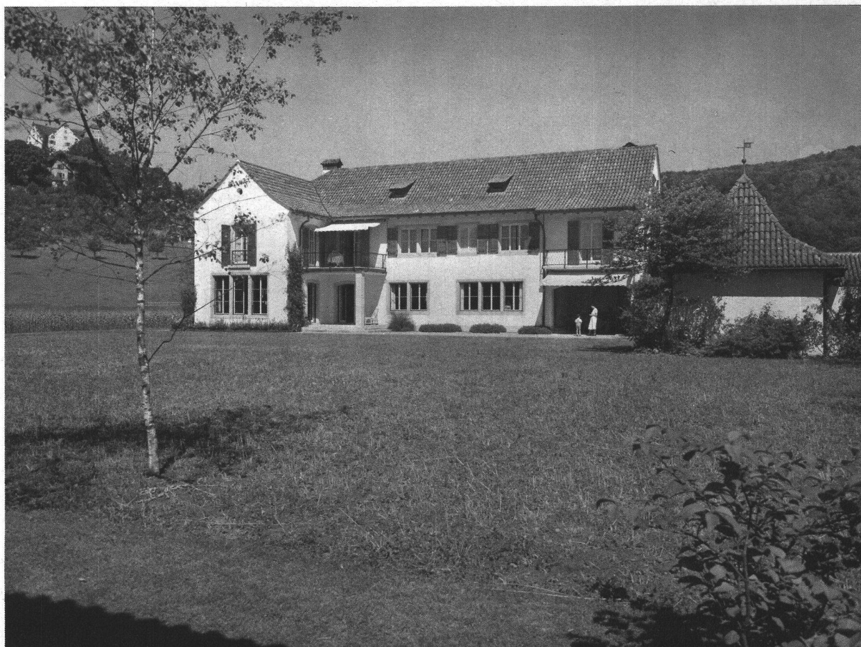
Gartenseite, Ansicht aus Süden. Dieser Bauflügel enthält die Wohn- und Schlafräume der Familie.
