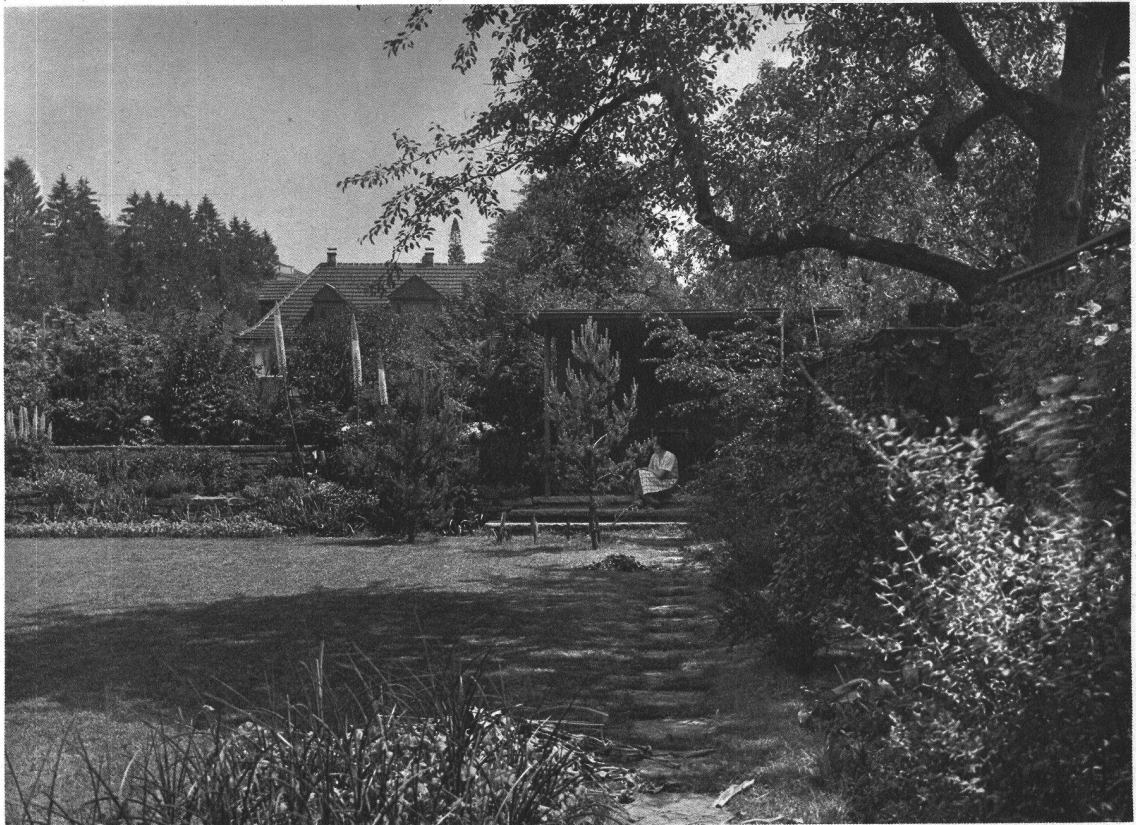
Ostecke des grossen Rasenplatzes mit Gartenhäuschen, von Südwesten gesehen
