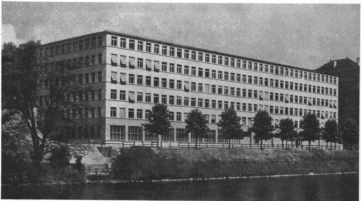
Stahltragwerk im Hochbau: Bürohaus Walche
