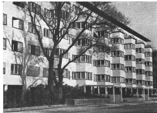
Miethausblock «Lindengut», Manessestrasse, Zürich 1937
