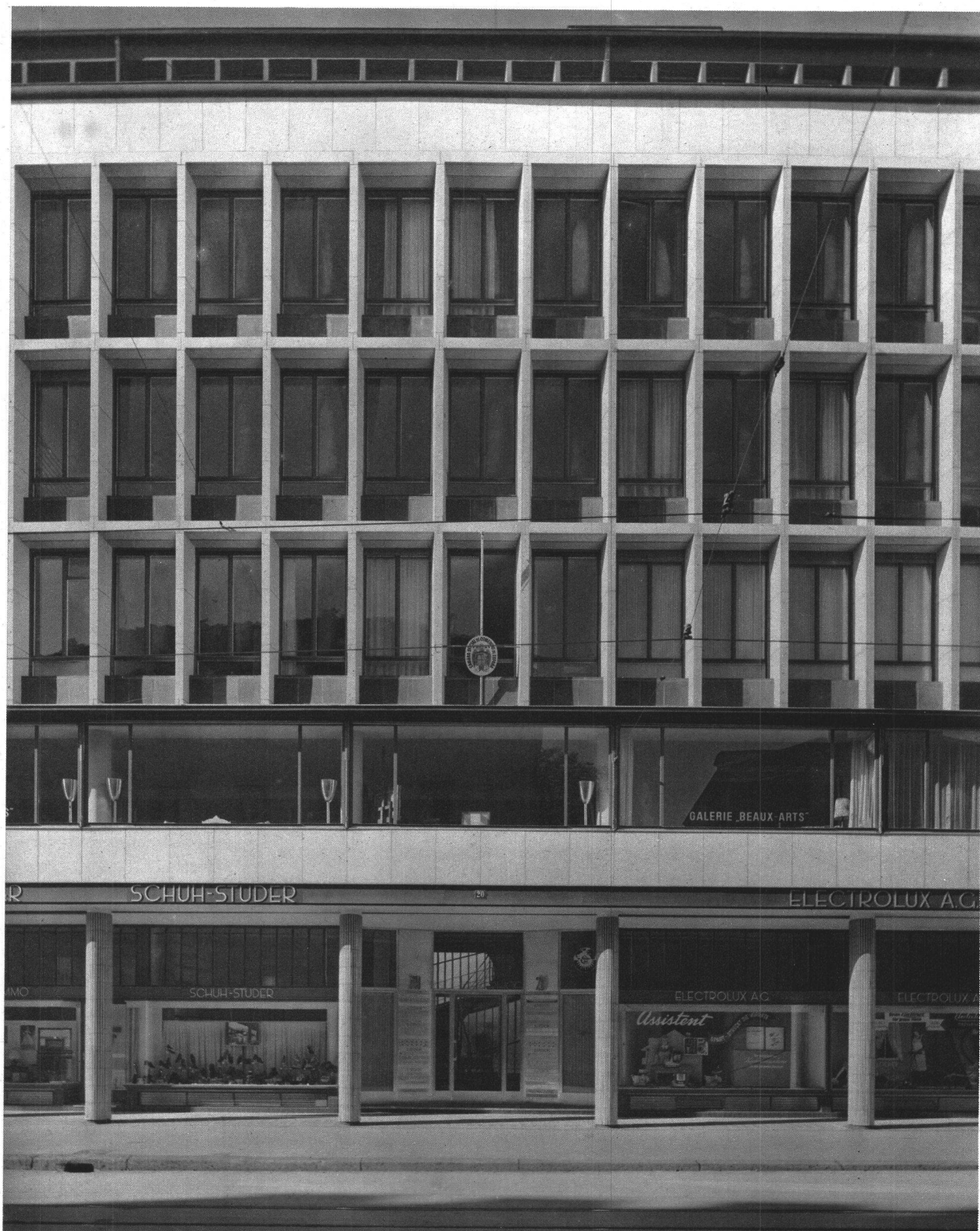
Bürohaus «Bleicherhof» am Bleicherweg, Zürich, 1939/40
