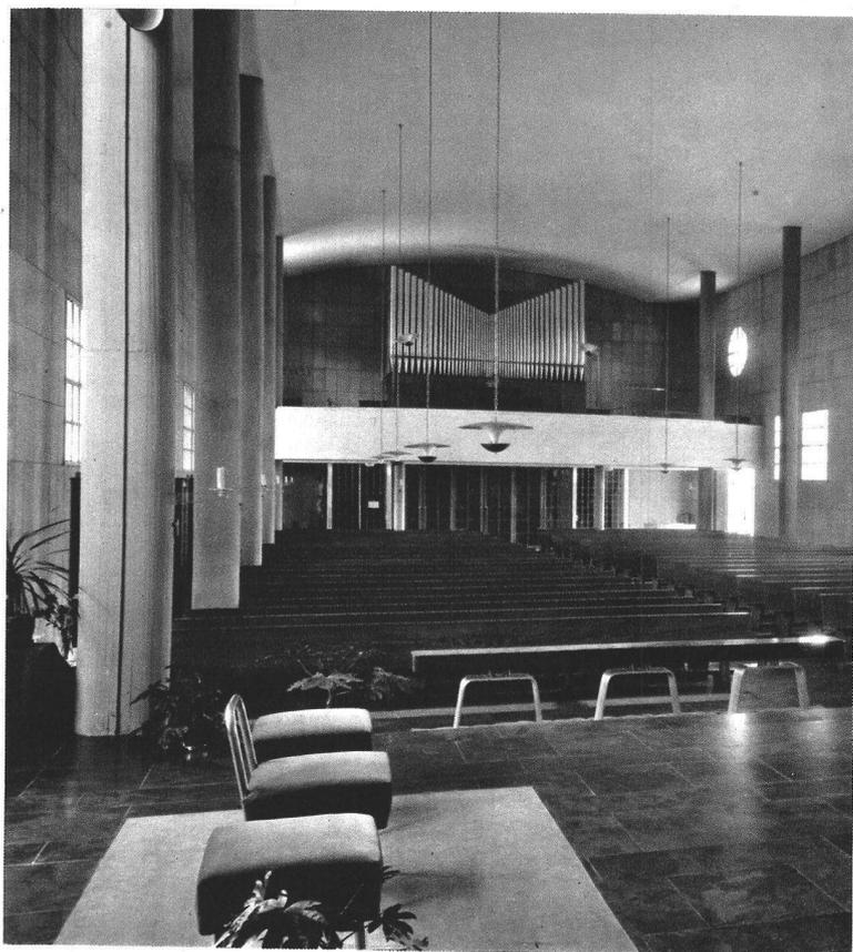
Bodenbelag in Colombey-Marmor, im Chor geschliffen, Altäre und Kommunionbank poliert. Wände aussen Sichtbeton, innen mit Tuffitplatten verkleidet. Pfeiler und Decke ebenfalls Sichtbeton gestrichen. Die Fenster im Schiff sind in blaugrünlichem opalisierendem Antikglas verglast; für das grosse Chorfenster sind Figurenfenster vorgesehen, ebenso für jene der Taufkapelle. Ueber dem Hauptaltar soll ein Baldachin aus Metall, mit Silber und Email geschmückt, errichtet werden.
