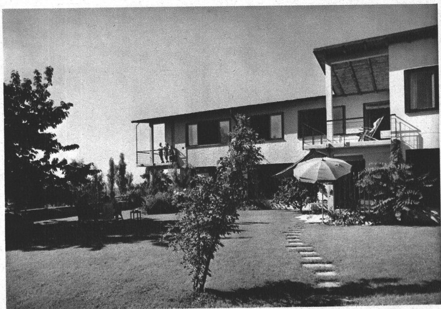
Haus S. in Zollikon Werner M. Moser, Arch. BSA Ansicht aus Süden, Gartenseite
