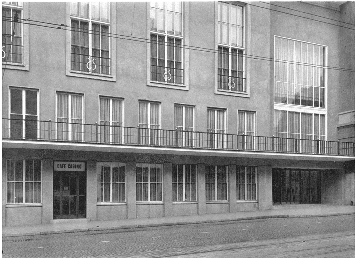
Ausschnitt der Fassade am Steinenberg mit Zugang zu den Sälen (an Stelle des früheren Durchgangs) und Nebeneingang zum Café. Der sattbraune, abgeriebene Verputz (Bärodur-Beimischung) in starker Kontrastwirkung zum helleren Kalkstein der Einfassungen und der weissgestrichenen Fenster und Gesimse, Erdgeschoss ebenfalls mit Kalksteinplatten (Estavayer) verkleidet
