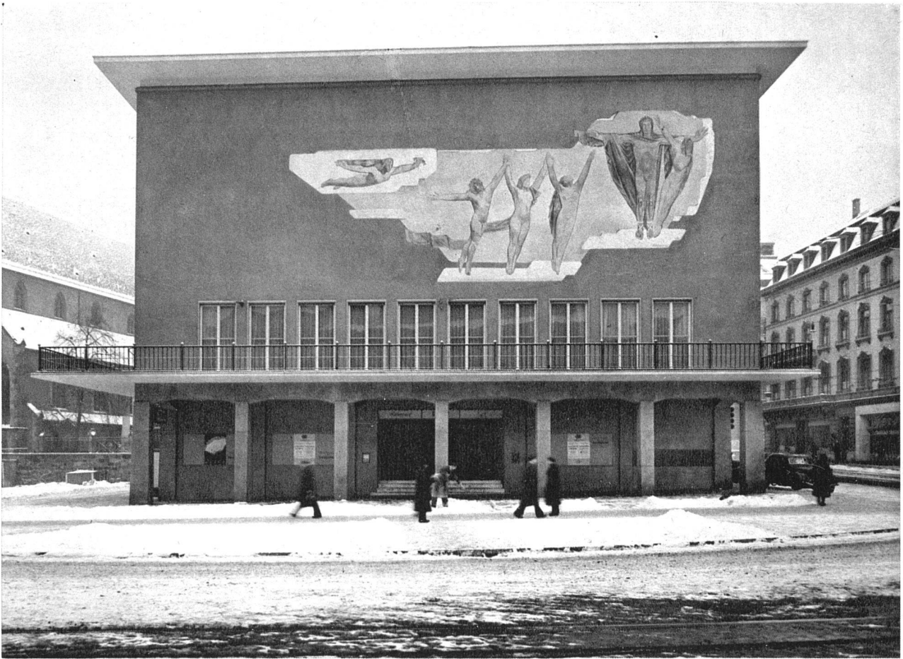
Casino Basel, Hauptfassade mit dem Fresko von A. H. Pellegrini, links Barfüsserkerche
