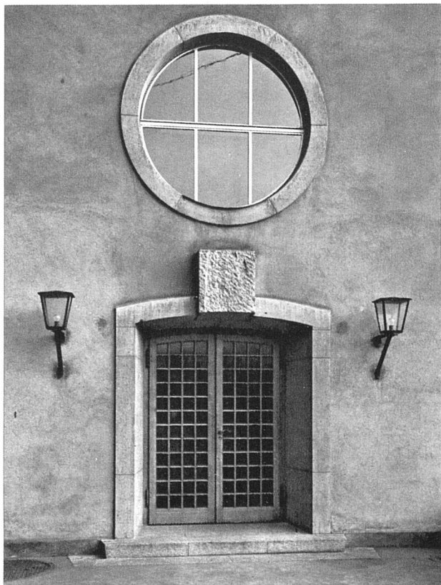
Nebeneingang zum Vestibül, Seite Barfüsserplatz Bossen zur späteren bildhauerischen Bearbeitung
