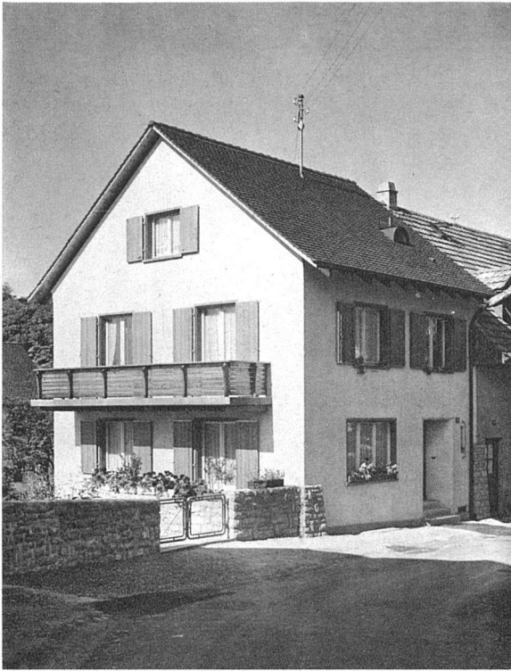
Wohnhaus W. P.-K., Riehen, Kirchstrasse 19 Architekt Max Henke, Riehen Beide Aufnahmen: C. Hoffmann SWB, Basel
