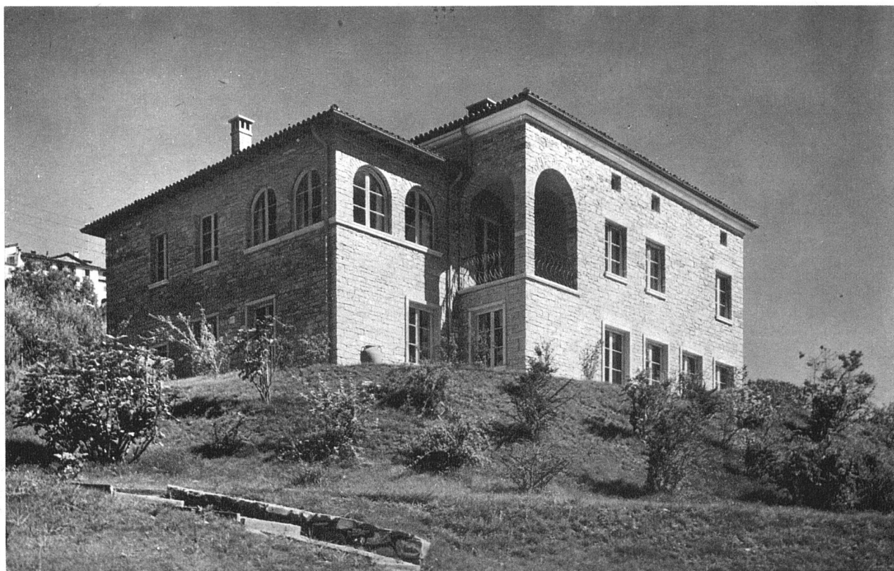
Veduta generale della casa, dal giardino. Muratura in pietrame di granito di Riviera a giunta magra, contorni delle aperture in granito bianco di Verzasca.
