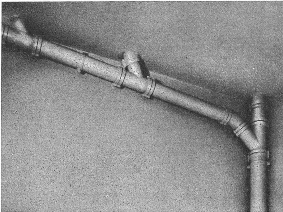
**Eternit - Installationsrohre, ihr leichtes Gewicht und die einfache Montage vereinfacht die Verlegung. Schallhemmendes und rostsicheres Material.**
