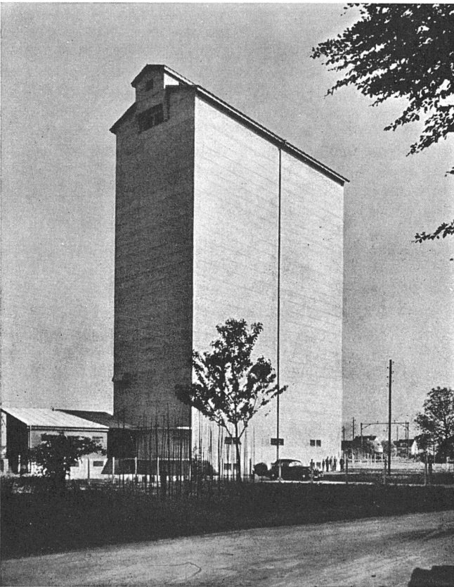
Neuer Silo der Neumühle Töb Ing. Büro A. Wickart & Co., Zürich
