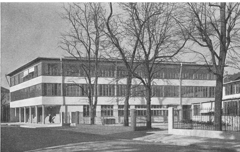
Neubau der Nationalzeitung Basel, Dr. h. c. A. Meili, Arch. BSA, Bauleitung: Von der Mühl & Oberrauch, Arch. BSA, Basel
