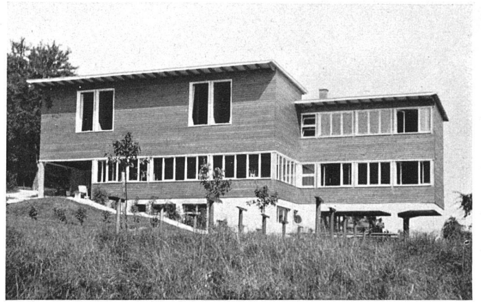
Abb. 7 Ansicht von Osten
