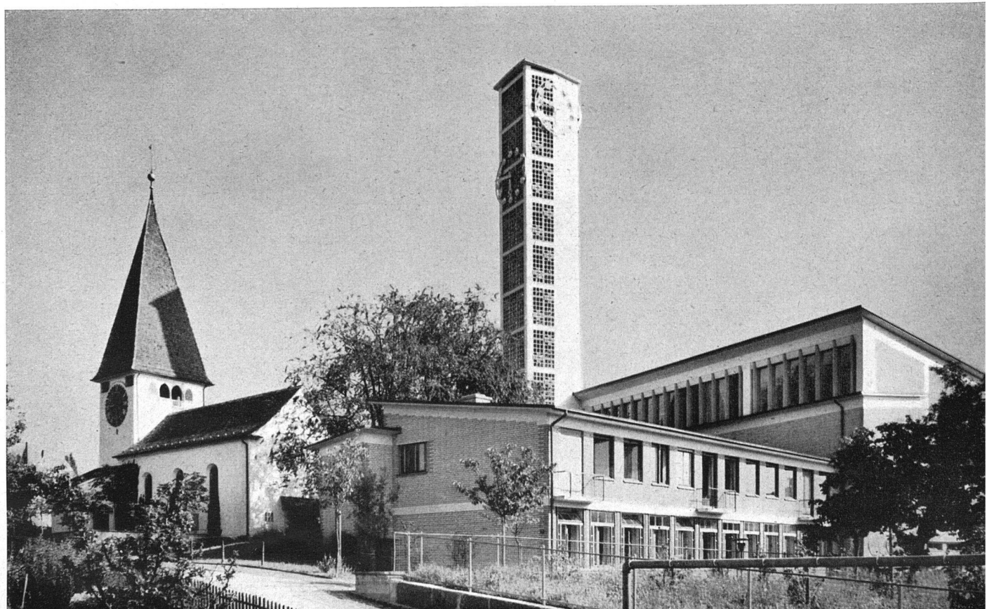
Abb. 3 Gesamtansicht von Nord
