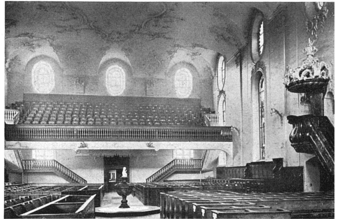
Innenraum der Kirche Wädenswil 1764–67
