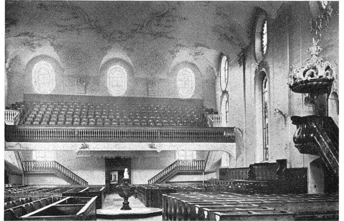
Innenraum der Kirche Wädenswil 1764–67
