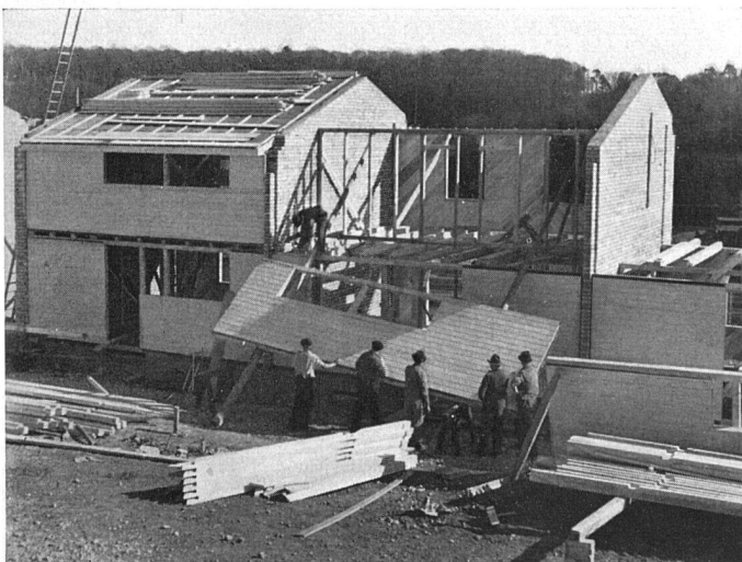
Montage eines Fassadenelementes
