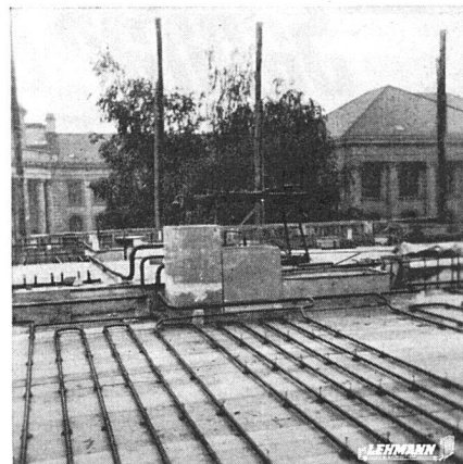
Einsetzen der Decken-Spiralen einer Strahlungsheizung
