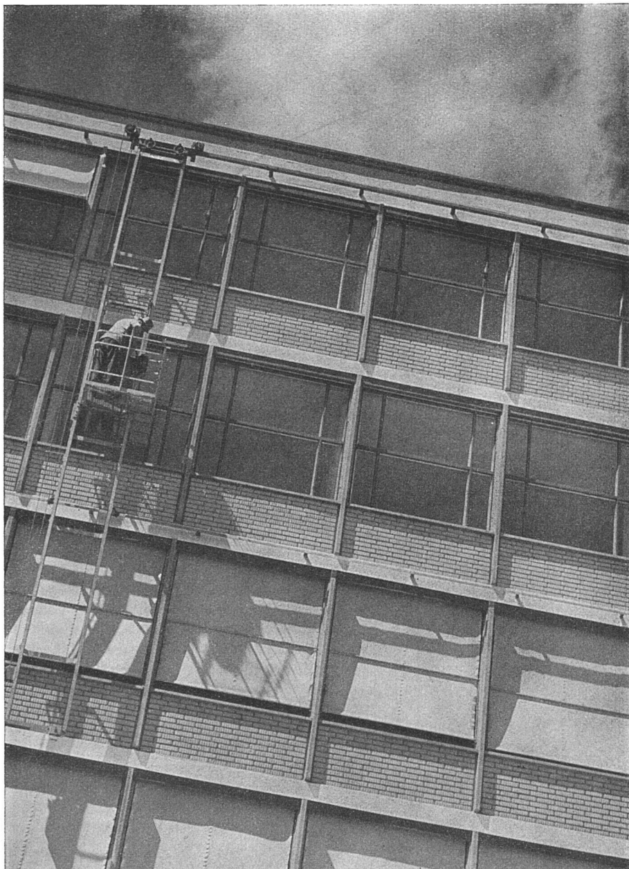
Ausschnitt Süd-Ostfassade mit Putzleiter
