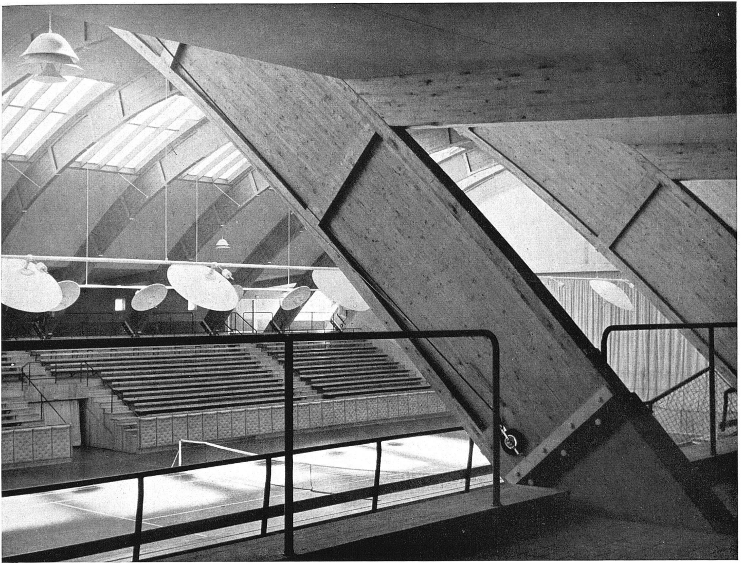
Innenansicht Verleimte «Törebodabinder» Spannweite 55 m
