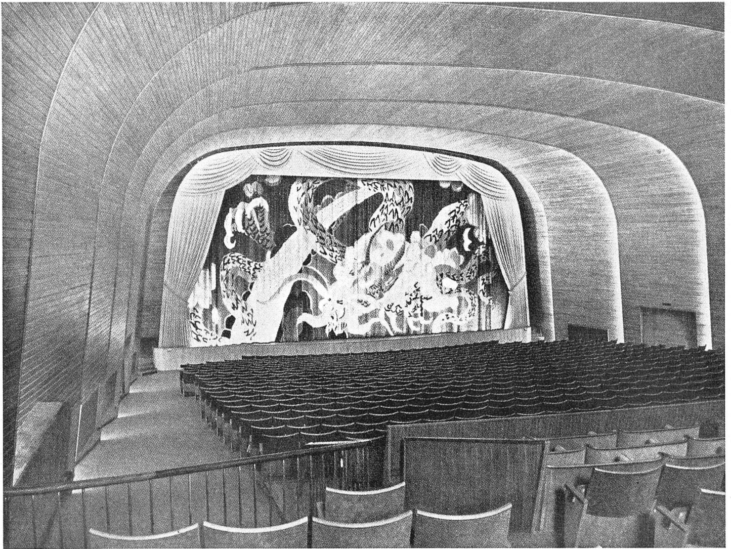
Kinotheater «Drachen» in Stockholm Architekt Ernst Grönvall Durchgehende Holzbekleidung mit Celluloselack matt geschliffen Verdeckte Beleuchtung Photo: A. Feininger, Stockholm-New York
