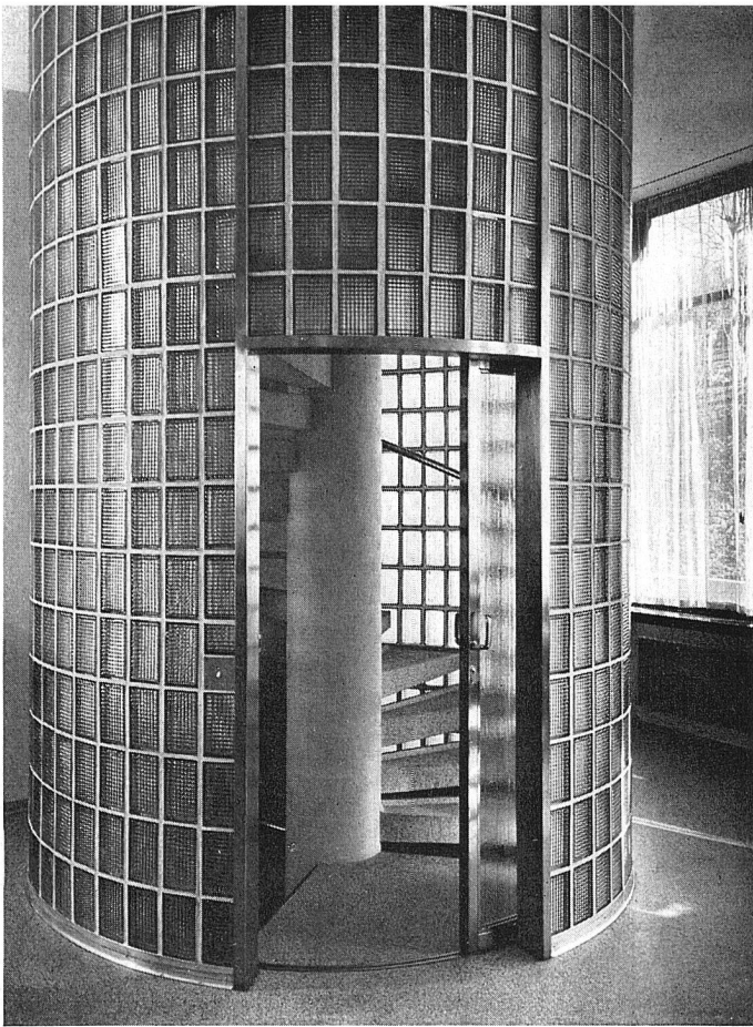
Wendeltreppe in Glasbausteingehäuse
