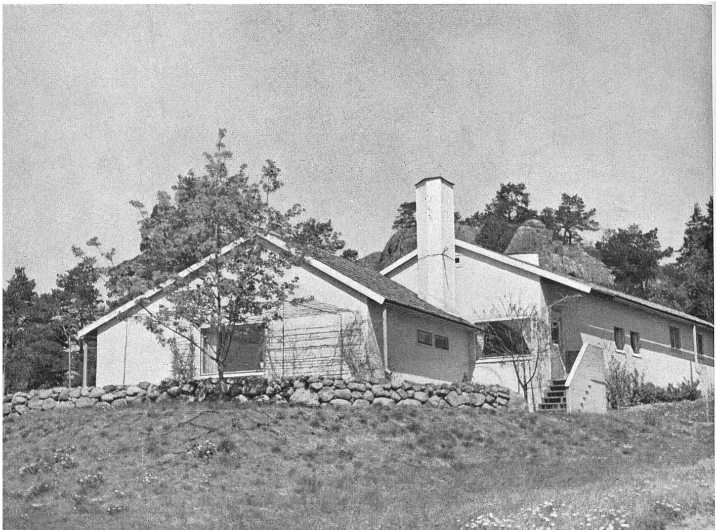
Südsicht von Süden, rechts Eingang
