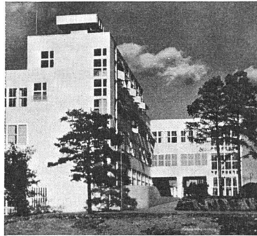
Telefonfabrik L. M. Ericsson in Midsommarkransen bei Stockholm, Architekt Ture Wennerholm, Stockholm
