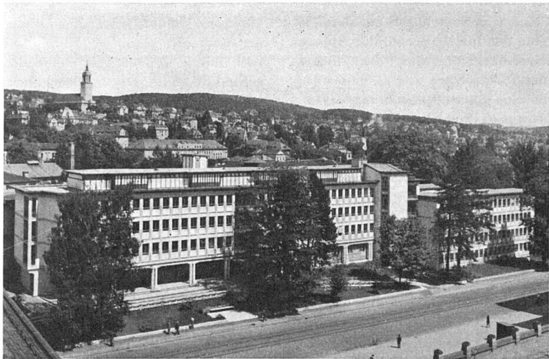
Der neue Polikliniktrakt des Kantonsspitals Zürich Photo: M. Wolgensinger SWB, Zürich
